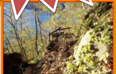
遊歩道が崩れています
