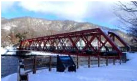
昨年9月から山線鉄橋の塗装作業が行われていましたが、12月下旬に塗装が終了しました。解体修理を終えた平成9年以来、初の「お色直し」です。塗り替えられた鉄橋は太陽の光が反射しピカピカに輝いています。
